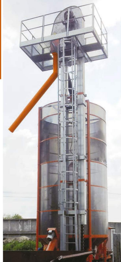
Bucket elevator Elevador de cangilones
